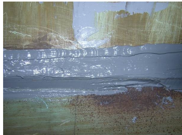
躯体接続部シーリング状況
