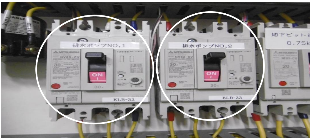
写真 2.1.15-2 更新した漏電遮断器（排水ポンプ用）
