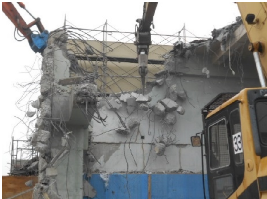
写真2.10.1(5)-6 既存部分の柱・壁・屋根の解体
