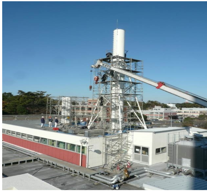
写真 2. 1. 17-2 第 1 排風機室スタック塗装工事
