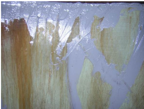
クラック補修状況
