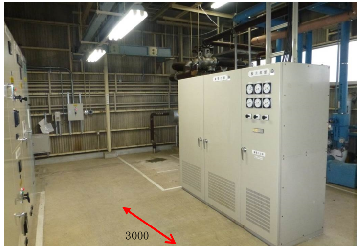
写真 2.1.16-1 直流盤移設
