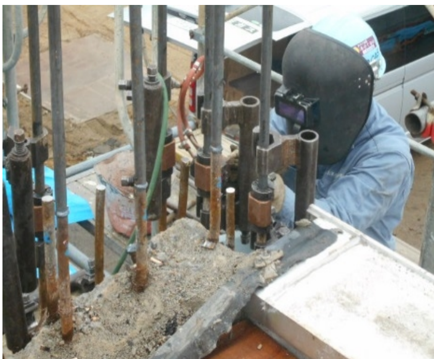
写真2.10.1(5)-3 エンクローズ溶接工法 (※)
