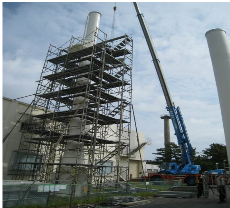
写真 2.1.17-1 第 2 排風機室スタック塗装工事
