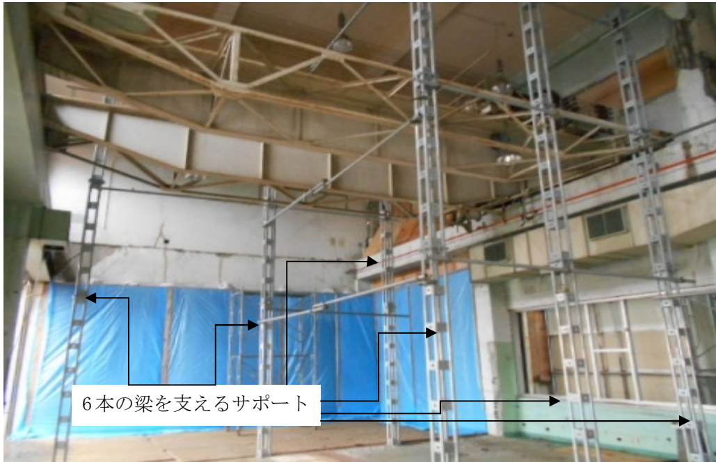
写真2.10.1(5)-4 15トンクレーン室サポート状況
