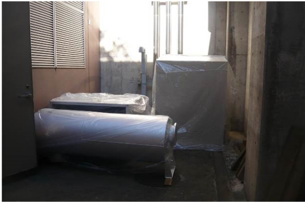
非常用発電機分割搬入仮置き状況
