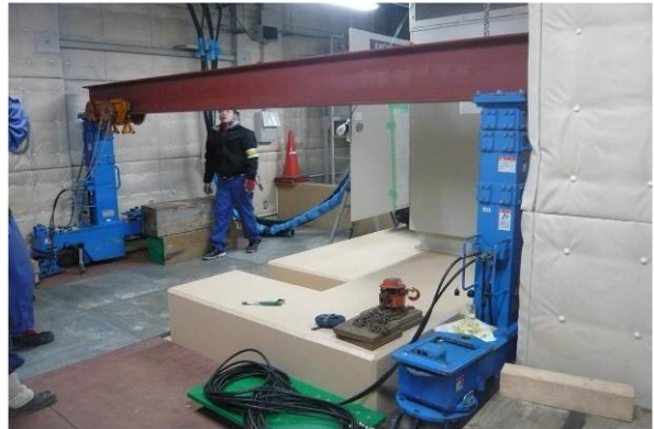
非常用発電機室内搬入状況
