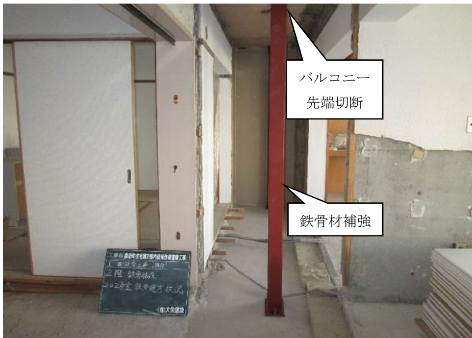
写真 2.10.1.(6)-6 天井裏バルコニー改修後
