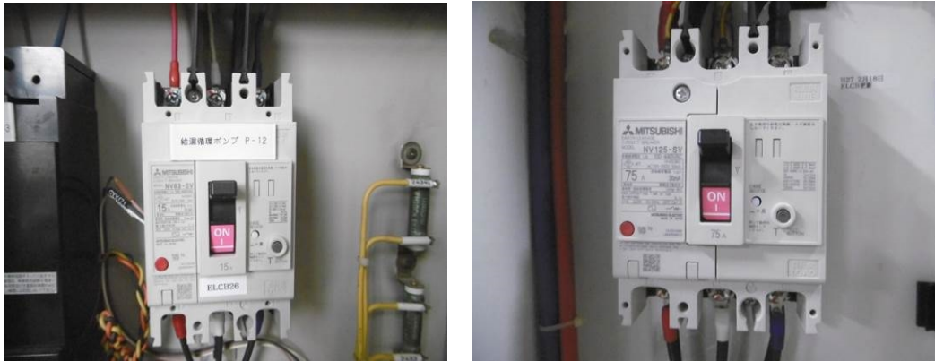
写真 2.1.15-1 更新後の漏電遮断器（循環ポンプ用及びヒーター用）
