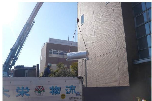
非常用発電機クレーン搬入状況 2
