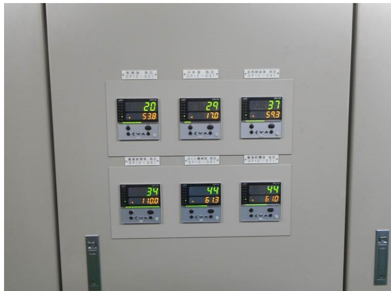
写真 2. 1. 7-1 更新した負圧指示調節計(上段の 3 台は昨年度更新したもの)
