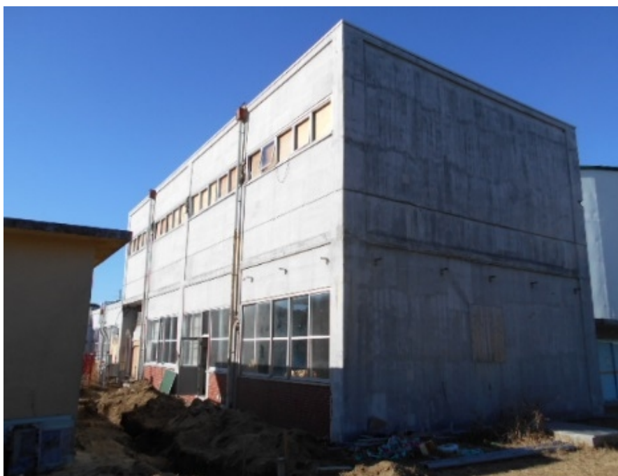
写真2.10.1(5)-2 15トンクレーン室外観
