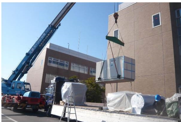
非常用発電機クレーン搬入状況 1
