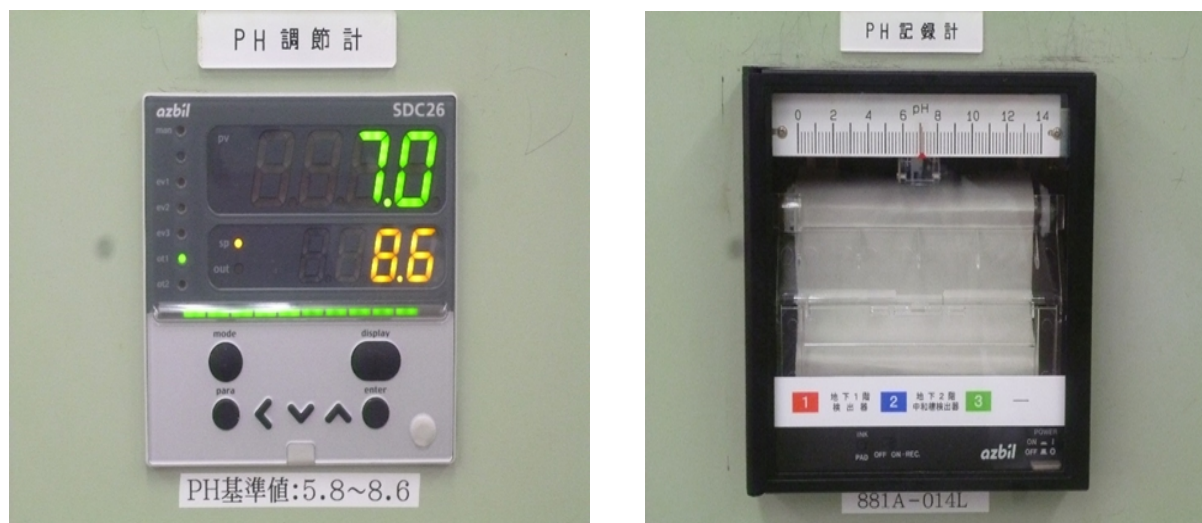
写真 2.1.14-1 pH 計他更新（pH 調節計及び pH 記録計）
