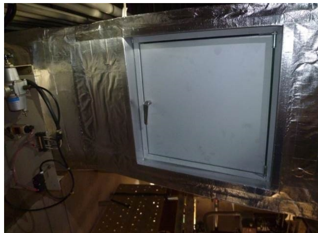
写真 2.1.13-1 第 1 系統給気ダンパ用点検口
