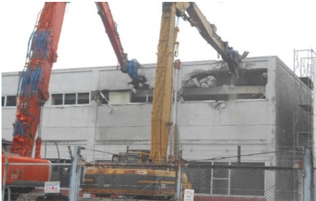
写真2.10.1(5)-5 2台の圧砕機による解体
