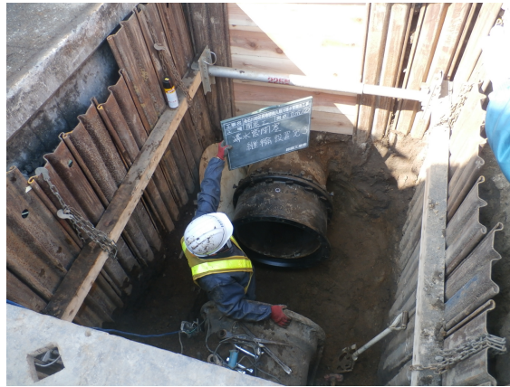
写真 2. 10. 2-1 久慈川導水管の廃止措置工事状況
